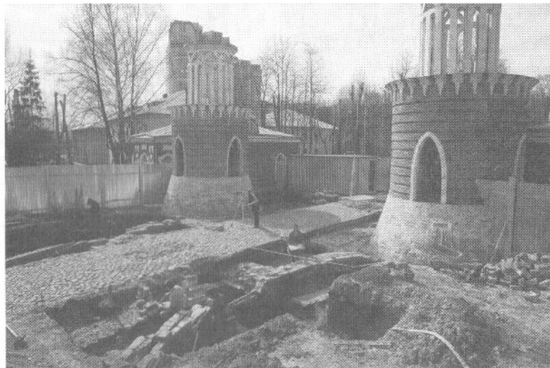
Обмерные работы на вскрытых кладках моста и расчищенной булыжной мостовой у въездных башен усадьбы. Апрель 2007 г. Фотография Ю. Е. Петрова
